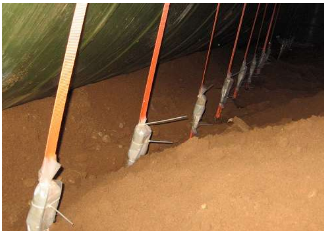
Установка емкости на плите, крепление стяжных ремней
