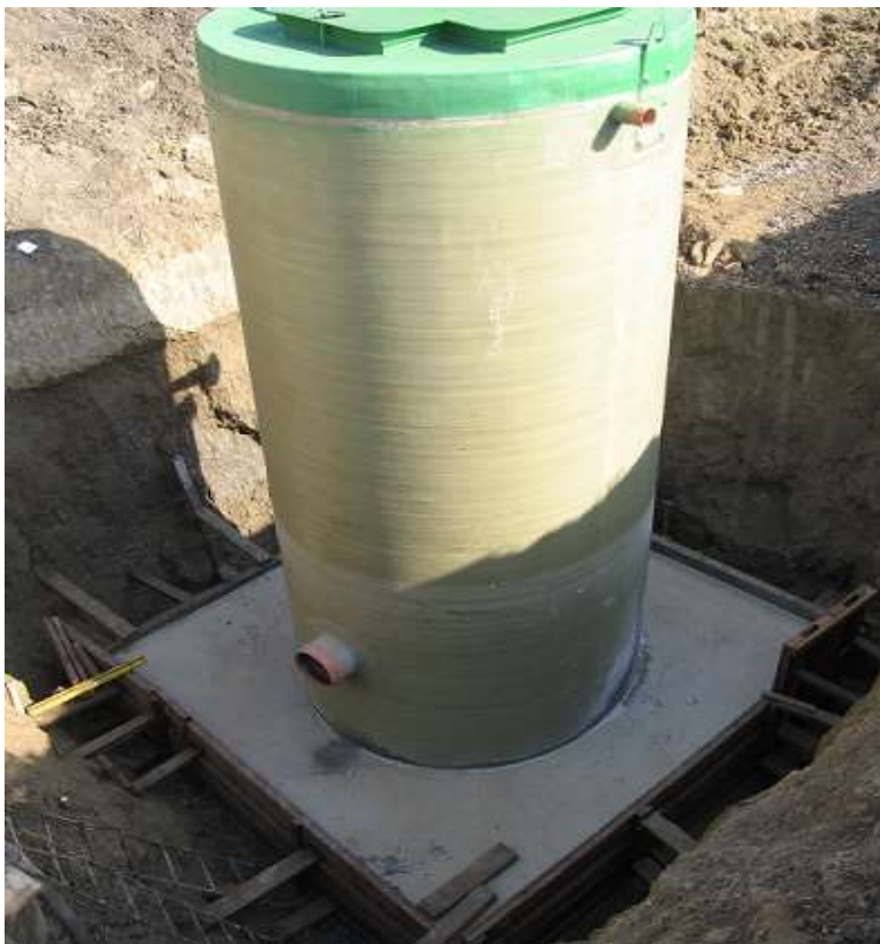
Установка вертикальной емкости, анкерение и бетонирование.
