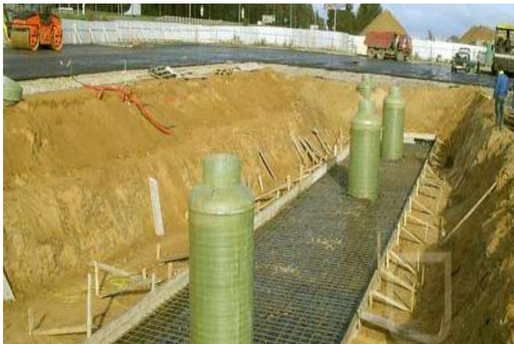
Изготовление распределительной плиты
