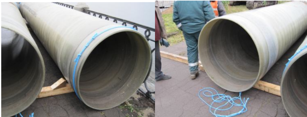
Рис 43 Складирование труб на площадке
