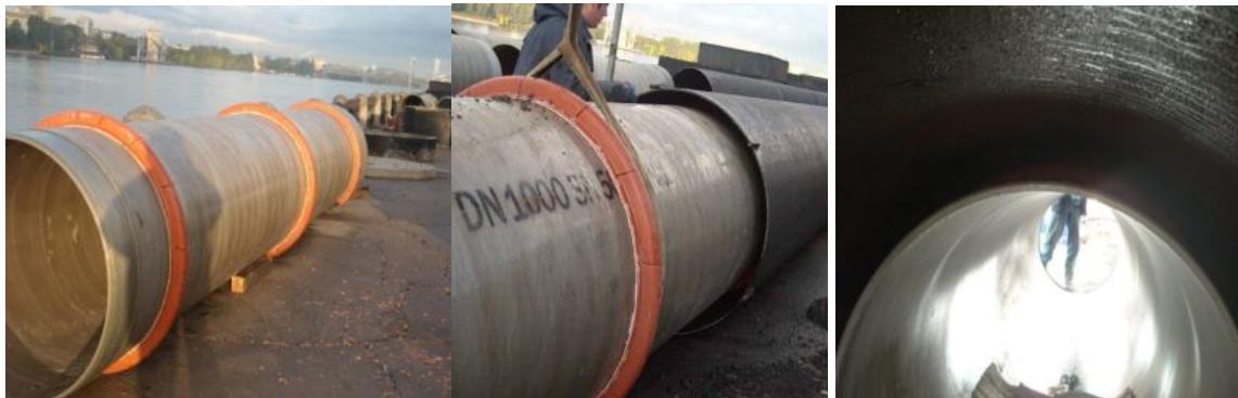
Способ протаскивания труба в трубе
