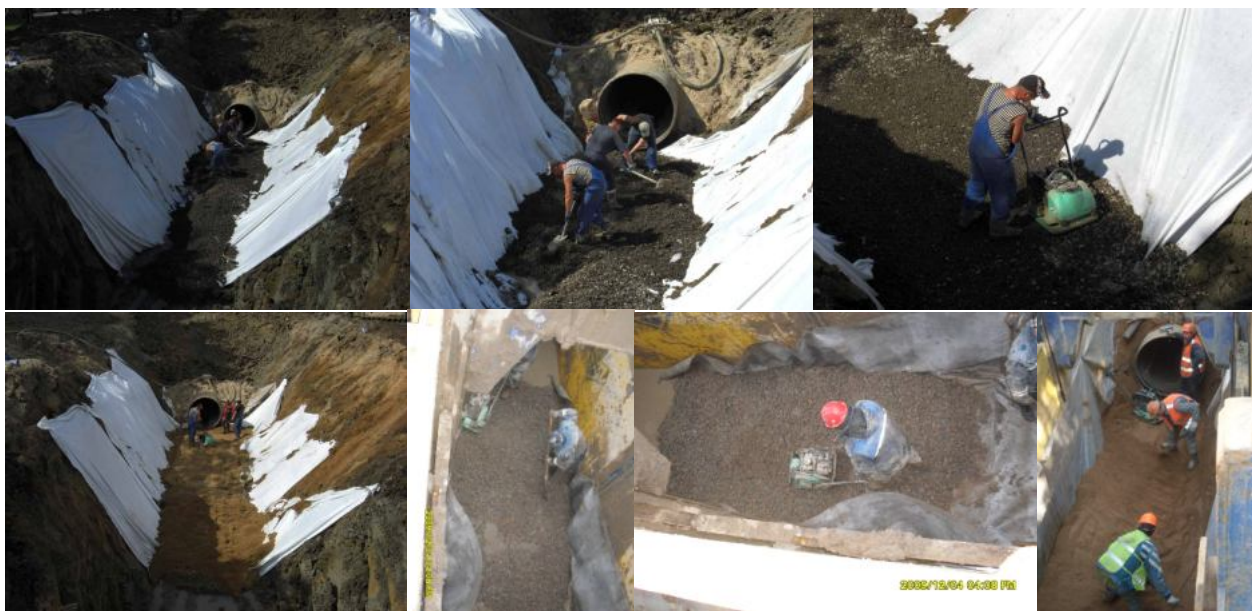
Рис 48 Устройства оснований под трубы
