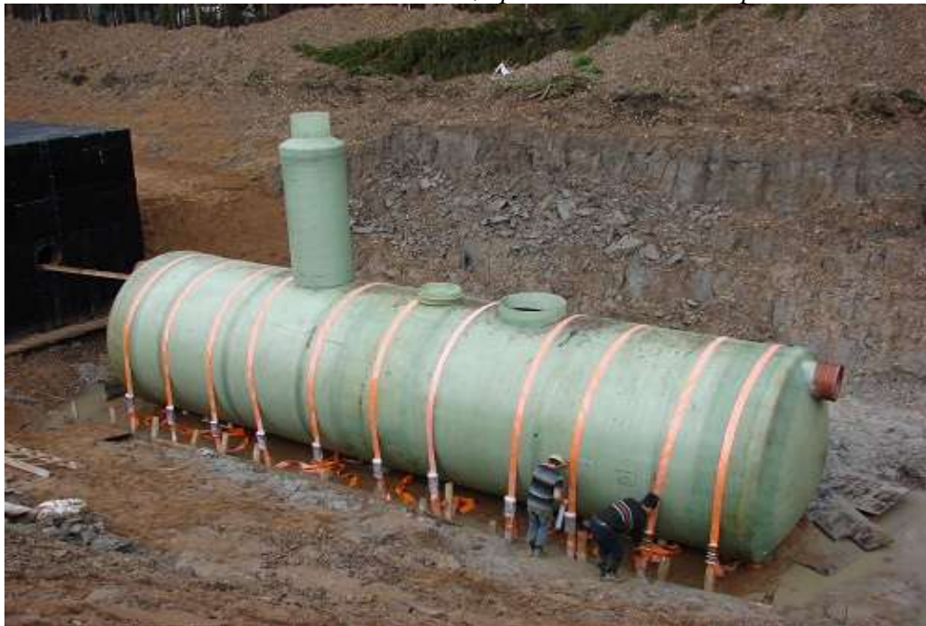
Установка емкости на плите, крепление стяжных ремней
